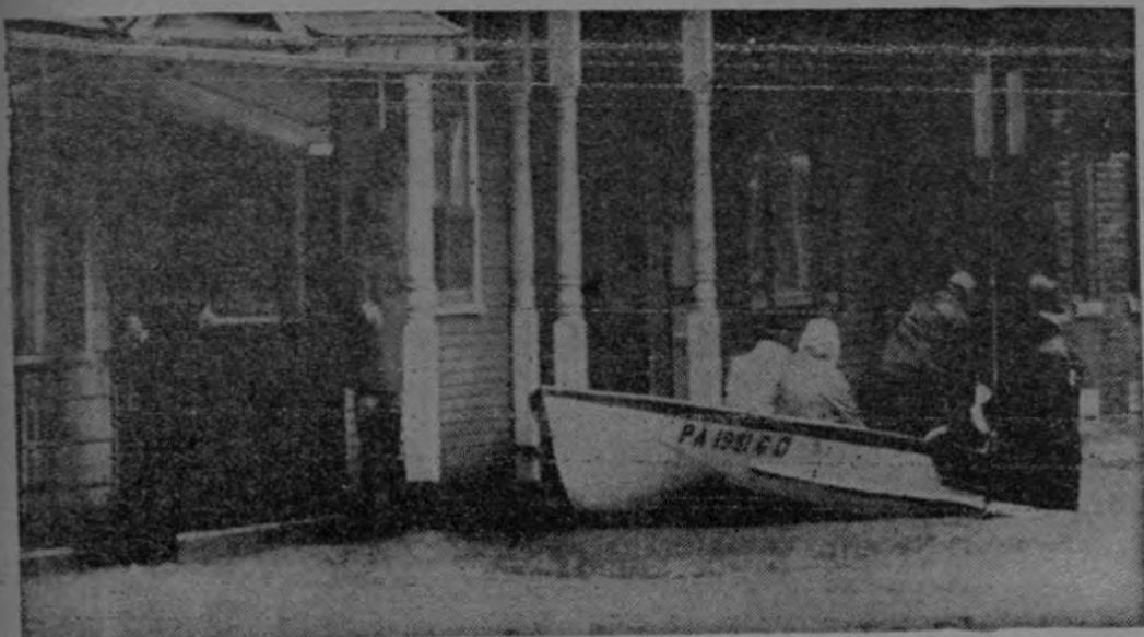
EVACUACION EN BOTE. Manhein. Trabajadores en bote, evacúan de sus propios hogares, debido a la inundación sufrida en Manhein. Temporalmente los trasladarán a los edificios del Cuerpo de Bomberos de la ciudad. (AP)
